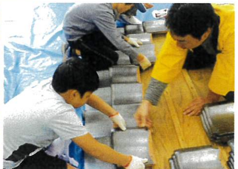
かわらぶき体験 熊本県瓦工業組合
